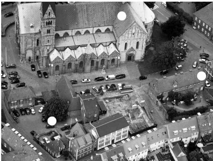
Fig. 3. Luftfoto af udgravningen optaget 2008. Cirklerne markerer de tidligere undersøgelser i området, som gav oplysninger om de ældste forhold på stedet.
